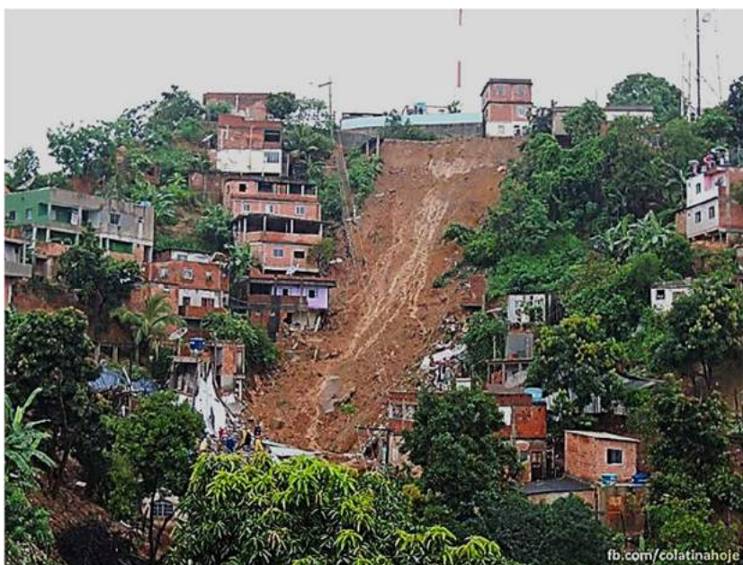
Figura 75 — Deslizamento no bairro São Marcos
