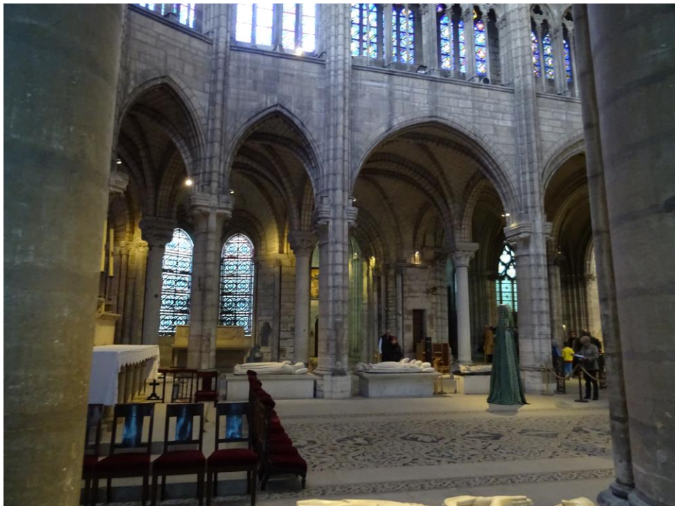
Figura 27 – Vista atual da abside da Basílica de Saint-Denis. Nela, vemos os arcos ogivais, a dupla fileira de colunas, as abóbadas de nervura, uma capela radiante (séc. XII) e o nível superior da cabeceira (séc. XIII). A abside é rodeada por túmulos de membros da realeza francesa. Fonte: Arquivo pessoal.
