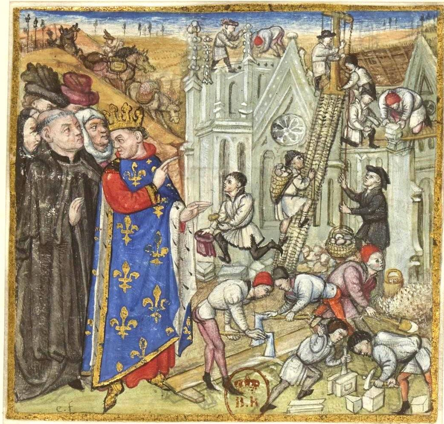
Figura 2 – Dagoberto I, à esquerda, com manto azul real decorado com flores-de-lis e uma coroa, supervisiona a construção do monastério de Saint-Denis. Ao lado do rei, um monge e pessoas da nobreza. À direita, operários trabalham na obra. A forma arquitetônica representada na iluminura é compatível com a arquitetura gótica, não com aquela do século VII. Isso porque na Idade Média, não existia a noção de tempo histórico tal qual concebemos hoje. 51 1460, Iluminura, 83 x 87 mm. Fonte: BIBLIOTHEQUE NATIONALE DE FRANCE, département Estampes et photographie, RESERVE 4-AD-133. http://gallica.bnf.fr/ark:/12148/btv1b105111504 , acesso em: 17 de fev. de 2015.
