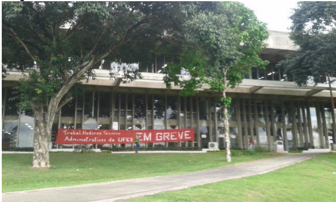
Fotografia 7 – Faixa da Greve na Biblioteca Central
