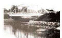
**1969** Um acidente com uma embarcação guindaste, que foi trazida para as obras no Porto de Tubarão, abalou a estrutura da ponte. A reforma, iniciada em 1972, só foi concluída no ano seguinte. A ponte perdeu os arcos laterais, mas ganhou mais uma faixa em cada sentido. A Ponte da Passagem se manteve até os dias atuais.
