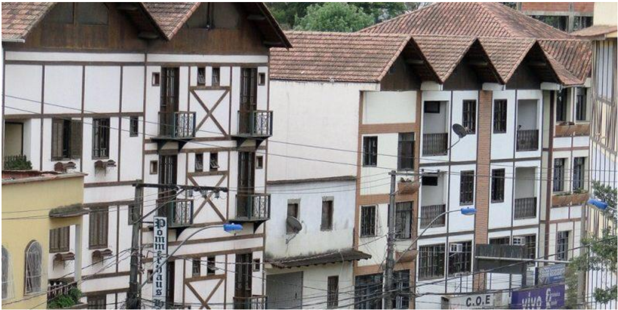
Figura 4: Centro da cidade de Santa Maria de Jetibá/ES – Detalhe das construções com Enxaimel
