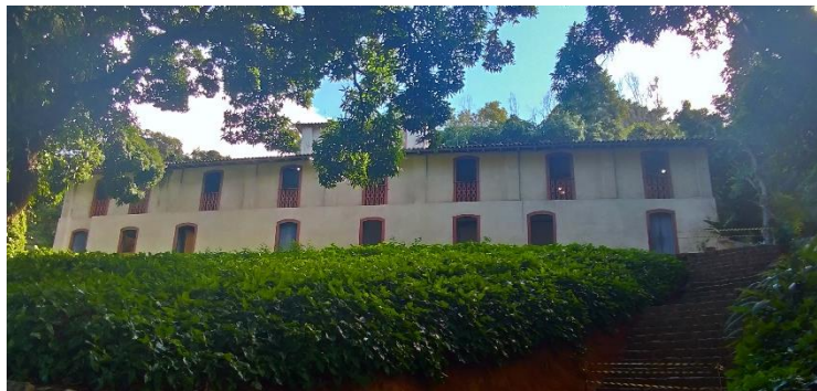
Figura 21 – Subida para o Edifício: Fachada Sul
