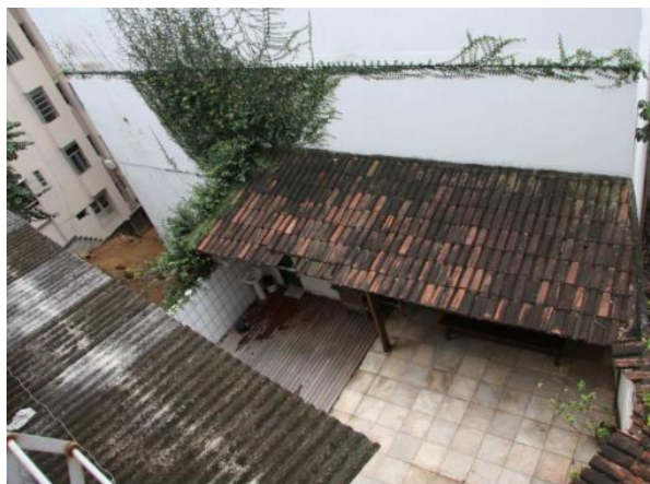
Figura 18 – Pátio Interno antes da construção do Anexo
