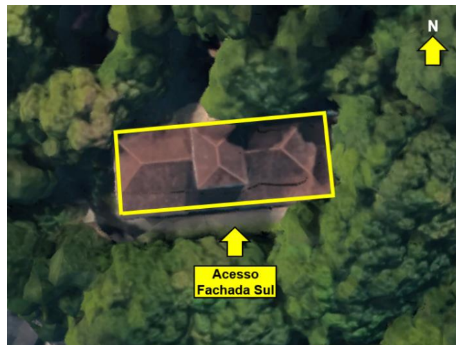
Figura 41 – Vista superior do Museu Solar Monjardim
