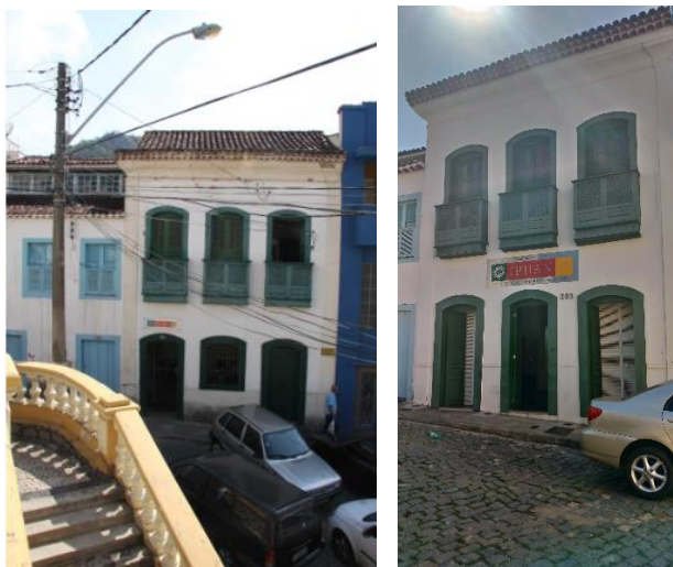
Figura 17 – Antes e depois da restauração de 2011: Fachada Principal (Sul)
