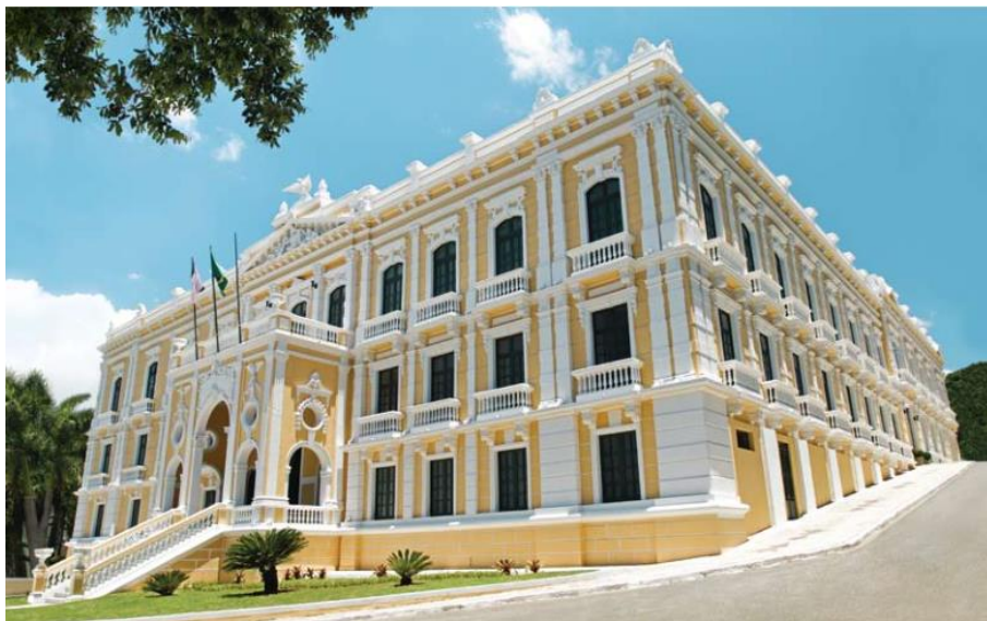
Figura 14 – Estado do Palácio Anchieta após a reforma em 2009
