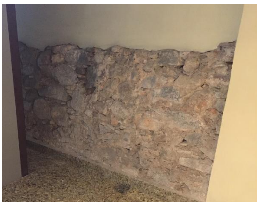
Figura 24 – Paredes de pedra e cal
