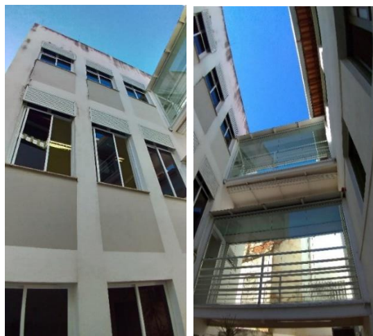
Figura 19 – Fachada do Anexo e Passarelas de ligação entre os dois edifícios
