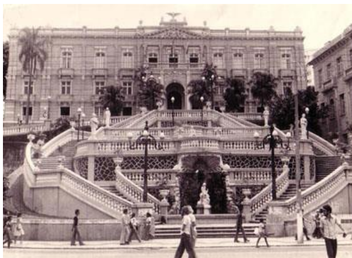
Figura 13 – Fachada Sul e Escadaria Bárbara Lindemberg
