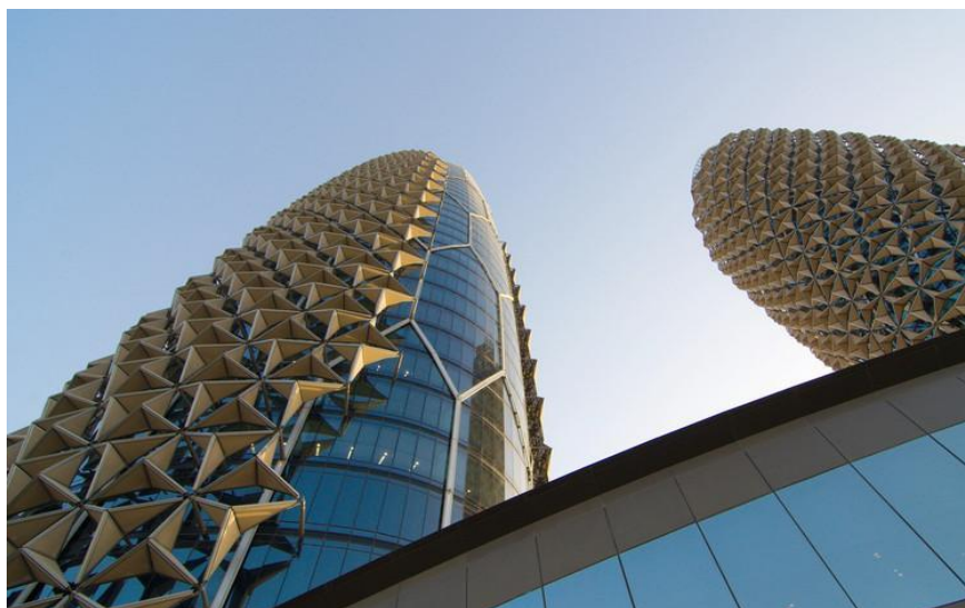
Figura 25: Dispositivo de fachada mashrabiya.
