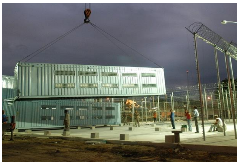
Figura 2 - Instalação das celas metálicas no presídio em Novo Horizonte na Serra (ES) em 2006.
