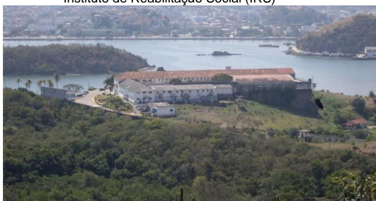
Figura 1 – Hospedaria de Imigrantes Pedra D'água em Vitória, atual Instituto de Reabilitação Social (IRS)
