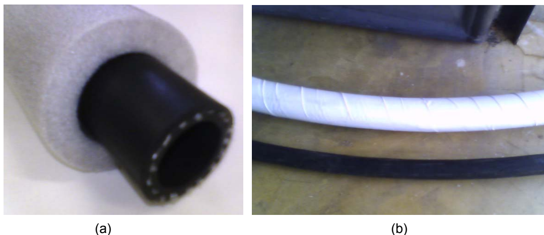
Figura 22 – (a) Mangueira de borracha recoberta com isolamento térmico. (b) Mangueira com isolamento (acima) e sem isolamento.
