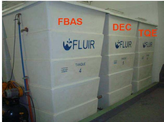
Figura 13: Tanque de Equalização de Vazão
