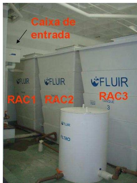
Figura 10: Reator Anaeróbico Compartimentado
