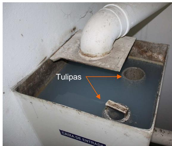
Figura 9: Caixa de entrada de água cinza bruta
